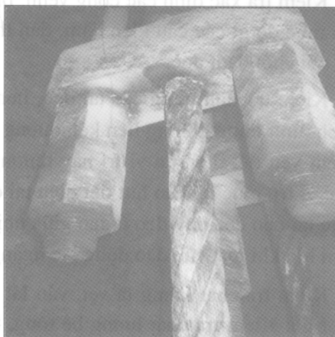
Hình 5.6: Ảnh chi tiết neo cáp
