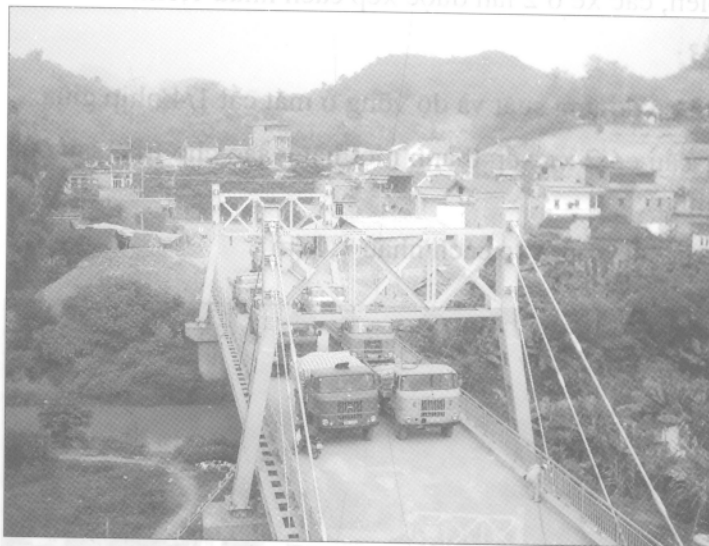
Hình 5.15: Sơ đồ xếp tải 1/2 nhịp chính
