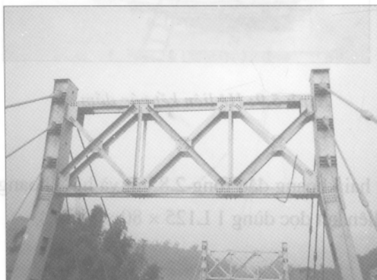
Hình 5.11: Hệ liên kết tháp cầu
